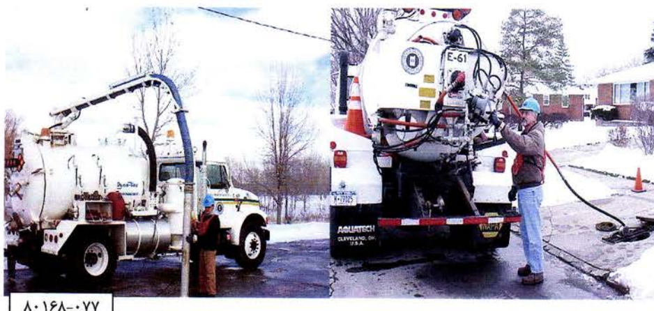
شکل ۷-۱: تانکر مورد استفاده برای شستشوی شبکه جمع آوری فاضلاب
